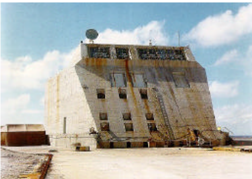
Blockhaus destiné à abriter les appareils de mesure, atoll de Moruroa (Tuamotu). Photo : D. Palacz, 2005
