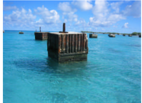
Blocs de béton destinés aux haubans des antennes et appareils de mesure près de la piste d'atterrissage de l'îlot de Totegegie (Mangareva – Gambier). Photos : D. Palacz, 2005
