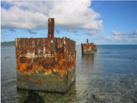
Blocs de béton destinés aux haubans des antennes et appareils de mesure près de la piste d'atterrissage de l'îlot de Totegegie (Mangareva – Gambier). Photos : D. Palacz, 2005
