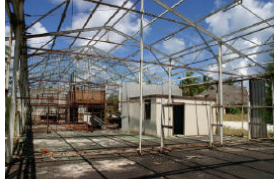
Vestiges de hangars sur l'atoll de Hao (Tuamotu). Photo : D. Palacz, 2005
