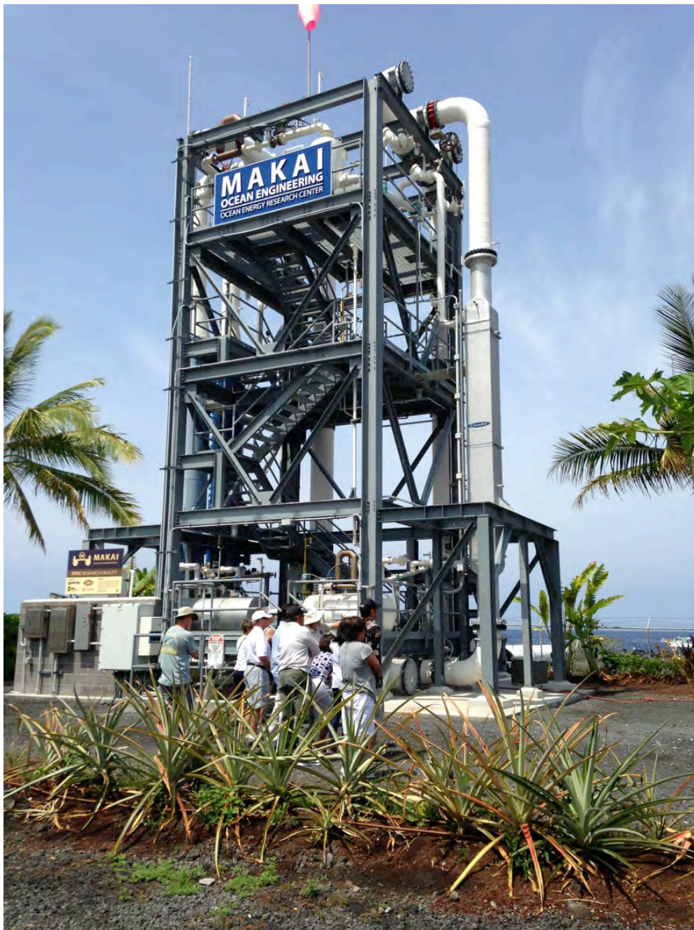
Centrale pilote OTEC de Hawaii à Kona – source : http://friendsofnelha.org
